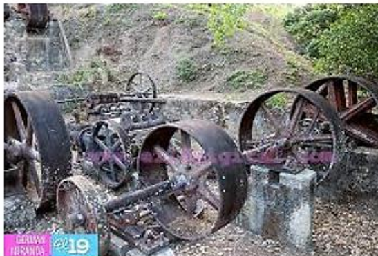
Ruinas de la mina San Albino
