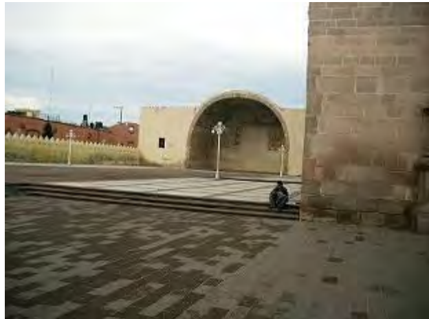
Capilla abierta en el Templo y ex-convento de San Nicolás de Tolentino, Actopan, Estado de Hidalgo.
