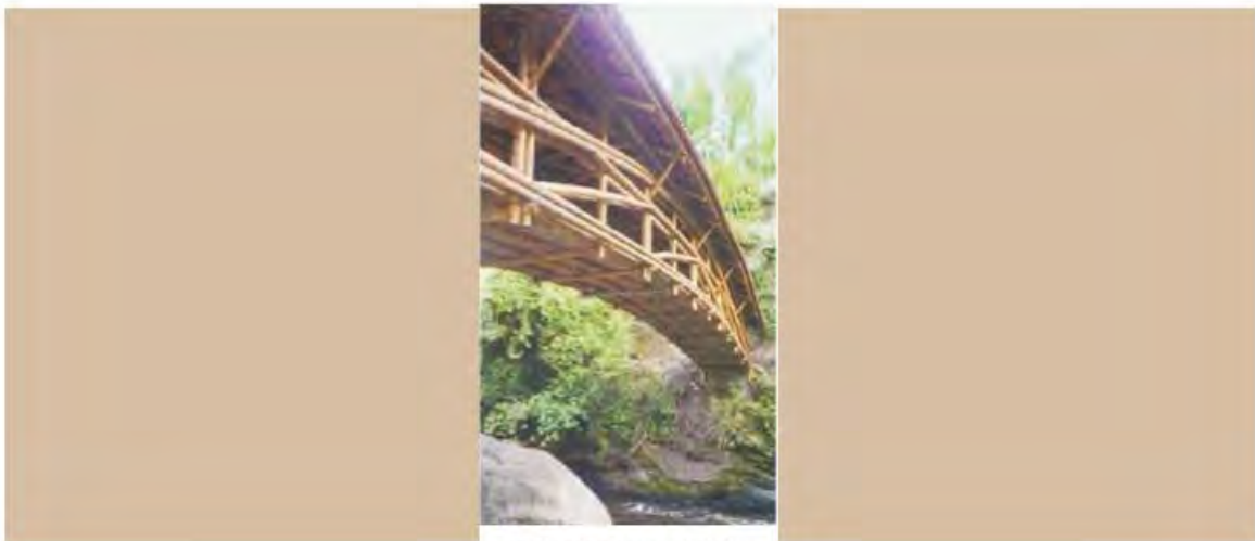
Foto 50. Barandal de bambú
