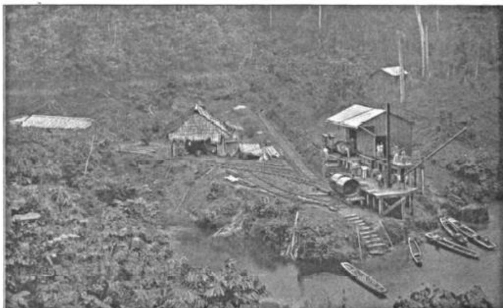
Fig. 3. Estación de Transborde en Miranda de la Mina Edén
