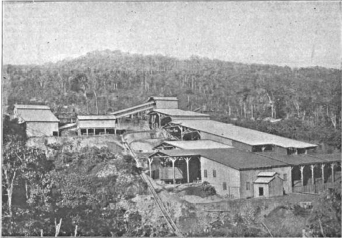
Fig. 5. Molino e Instalación para la Cianuración en la Mina Edén
