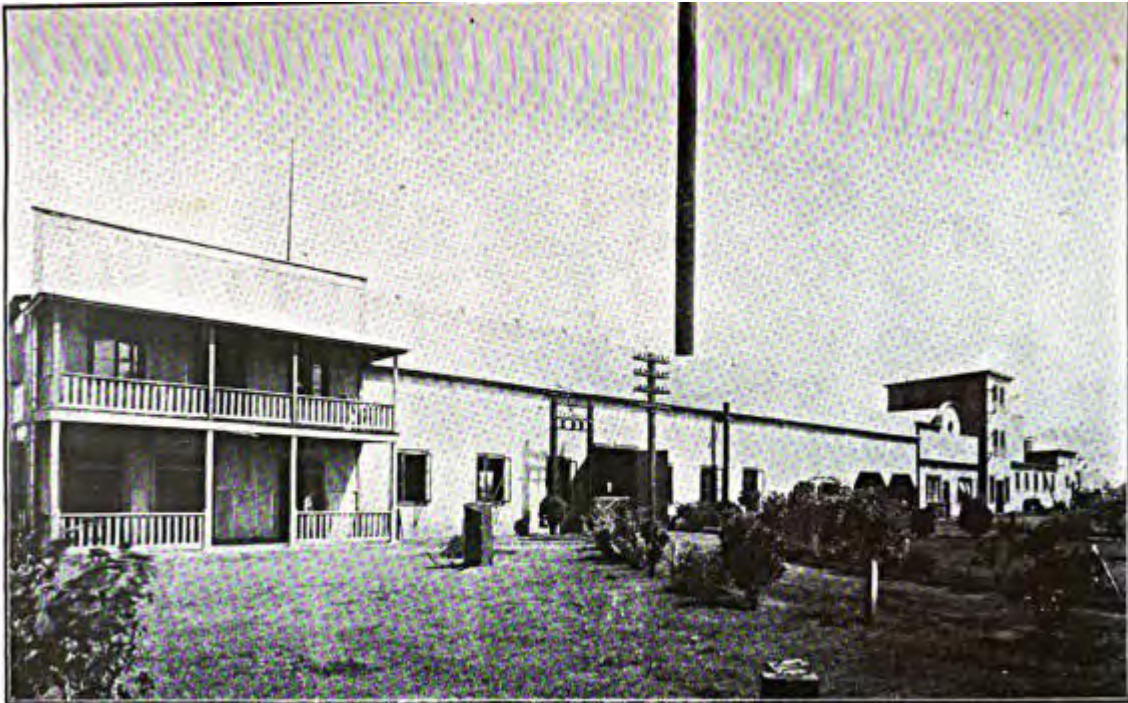
Managua, planta eléctrica y fábrica de hielo. Fuente Matamoros, J. J. La República de Nicaragua. Managua: Tipogr. y Encuadernación Internacional, 1906.
