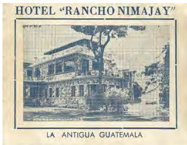
Postal del Hotel Rancho Nimajay en donde funcionó el ENCASER.
