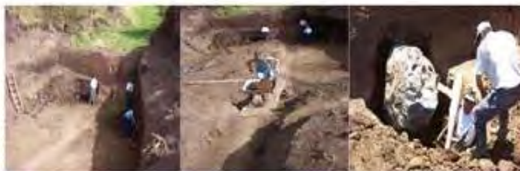
Fotos 1 y 2: excavación con retro excavadora (10 horas) y 15 días (45 días hombre) de trabajo a mano. Foto 3: Complicaciones: una piedra en la excavación
