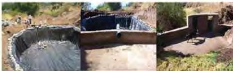
Foto 7: geo membrana y canal de drenaje instalados. Foto 8. Muro a la entrada del tanque. Foto 9: pared de 2 compuertas a entrada del cañón
