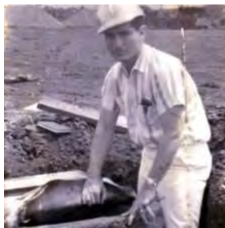
Eddy Kühl inspecciona las cajas de registro, 1968
