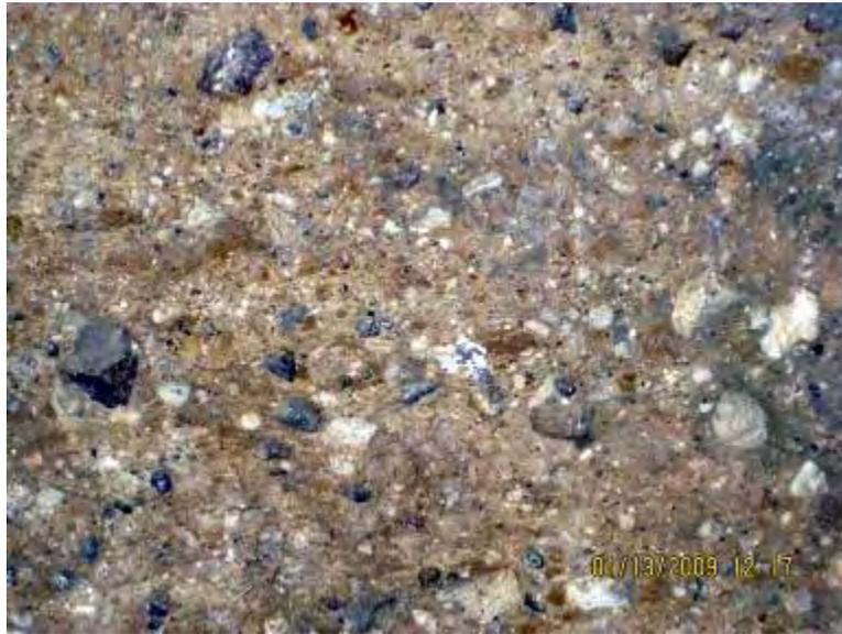
**Foto 1: Detalle del material usado en la pared de tapia, es igual al mortero de cal y ceniza usado para unir los ladrillos. Su composición es similar al de la ceniza volcánica sobre la que se asientan las ruinas. Las partículas blancas son piedra pómez.**
