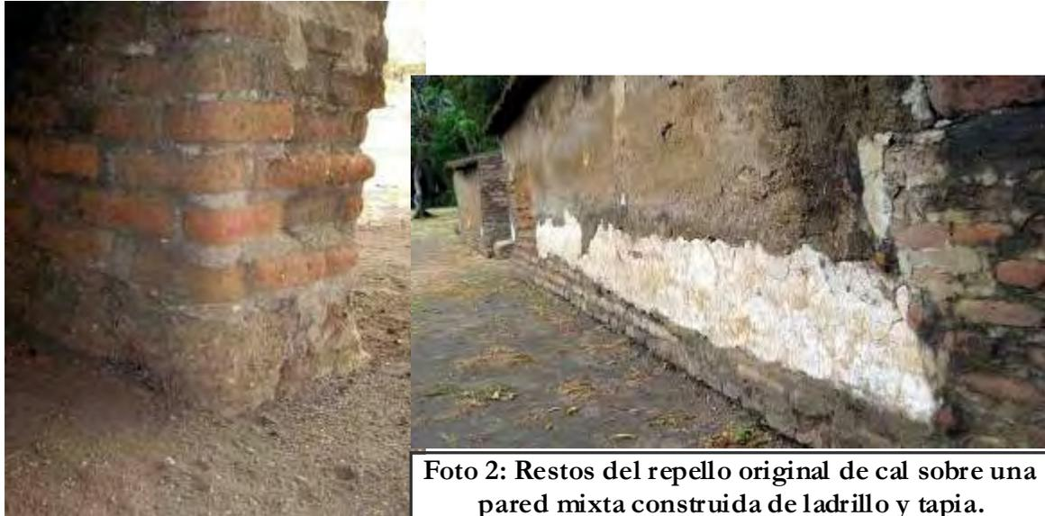
Foto 2: Restos del repello original de cal sobre una pared mixta construida de ladrillo y tapia.
