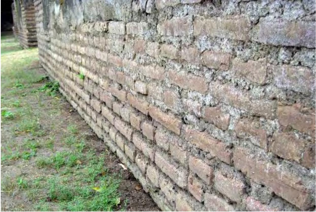
**Foto 4: Ordenamiento de los ladrillos, capas a lo largo alternando con capas a lo ancho.**
