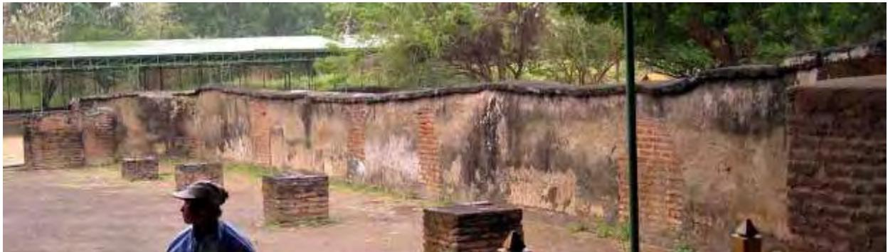
**Foto 5: Pared con contrafuertes de ladrillo y paredes intermedias de tapia en la Iglesia de La Merced**
